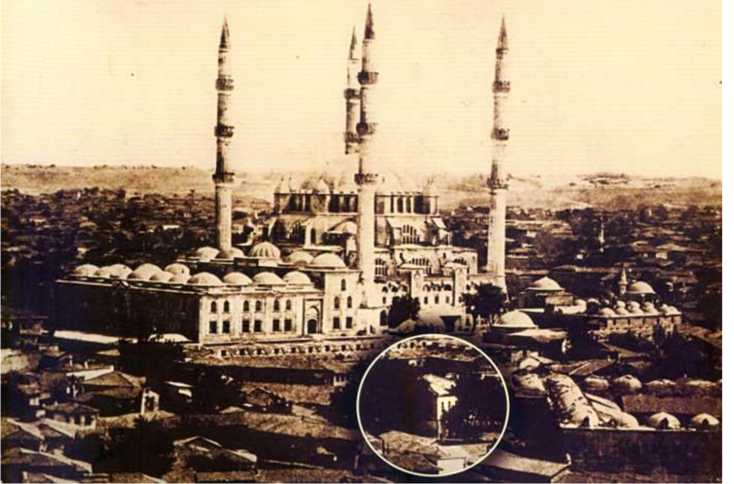
1857, İlk Rüştiye Binası (Faruk Etiker arşivi)
